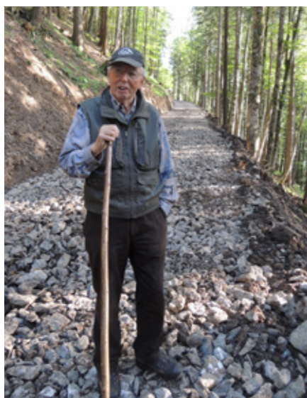
Altobmann Paul Peter während der Bauarbeiten am Krebswand-Stichweg im Juni 2015.
